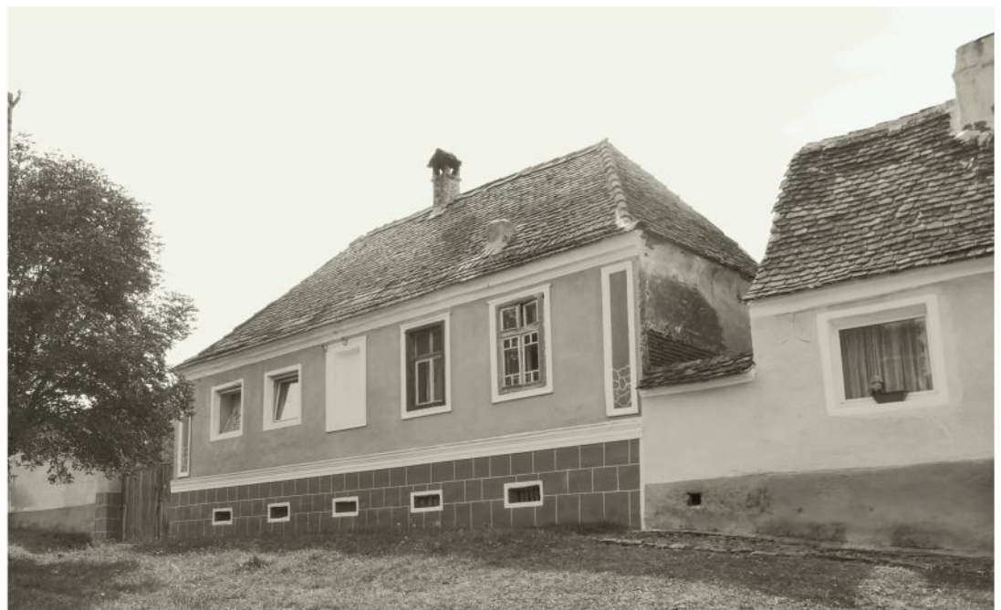
Das stattliche Haus in der Backgasse 322
