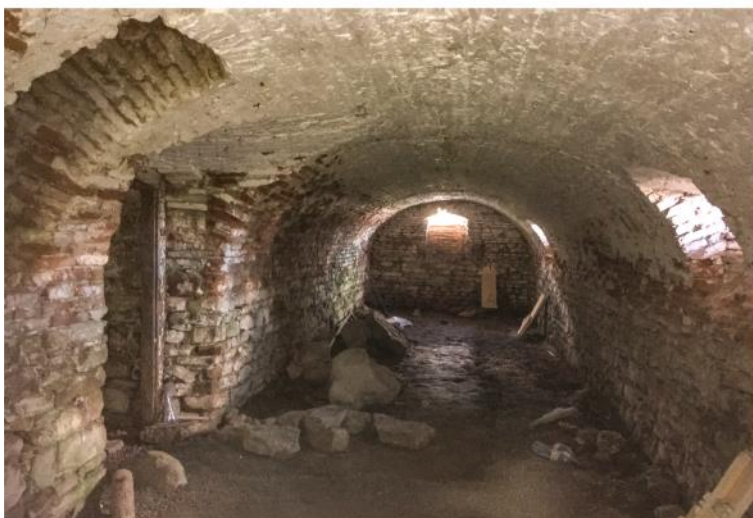
Im gewölbten Keller der alten Schule wurden Drainagen gesetzt und das Gemäuer vom Schimmel befreit. Şerban Bărligea, der Besitzer der Schule, erklärte uns begeistert die lfd. Arbeiten.
